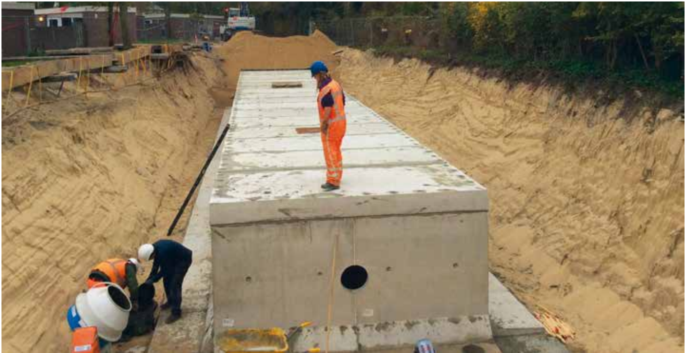
▲ In aanleg: Infiltratiekelder Egmond aan Zee
