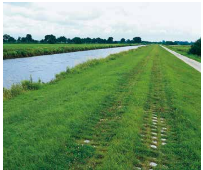
Latere verbreding in bochten en opritten bij landbouwwegen. Voertuigen blijven zo op de verharde weg en maken de zachte berm van de weg niet kapot. Met Multipode is het mogelijk een bermverharding ook in bochten te maken met complete steenformaties zonder te zagen of te knippen.
